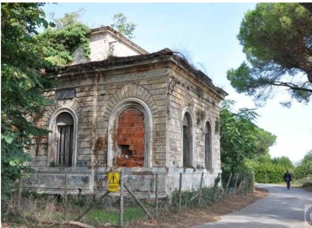
Строительная площадка ^ радиотелеграфной станции Маркони I сегодня
