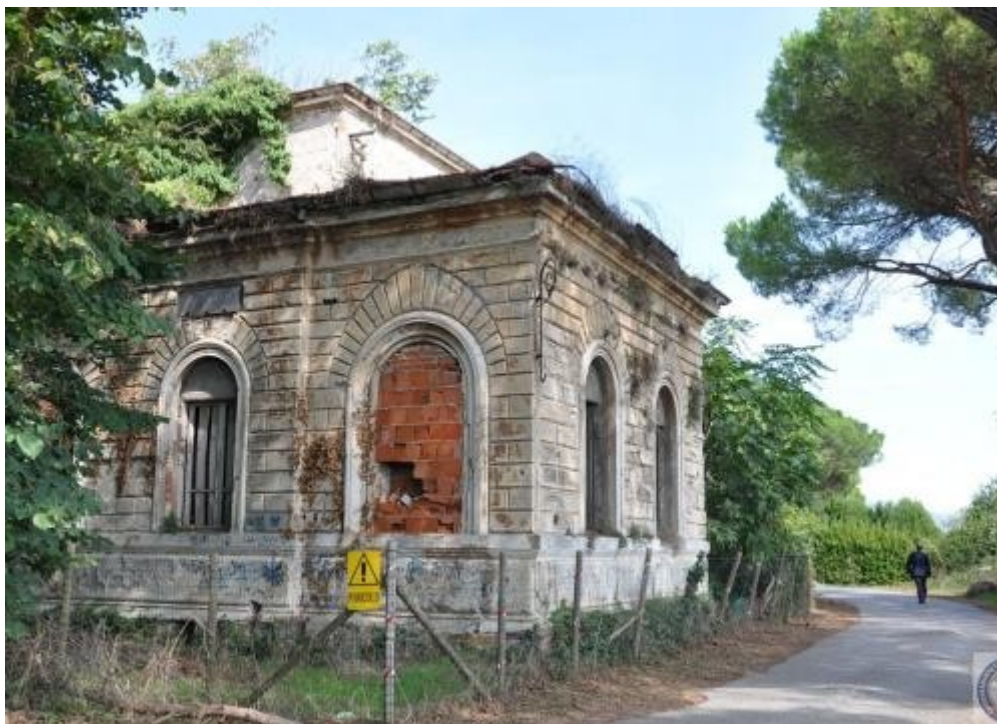
Le site de construction de la 1 re Station Radiotélégraphique de Marconi, aujourd'hui.
