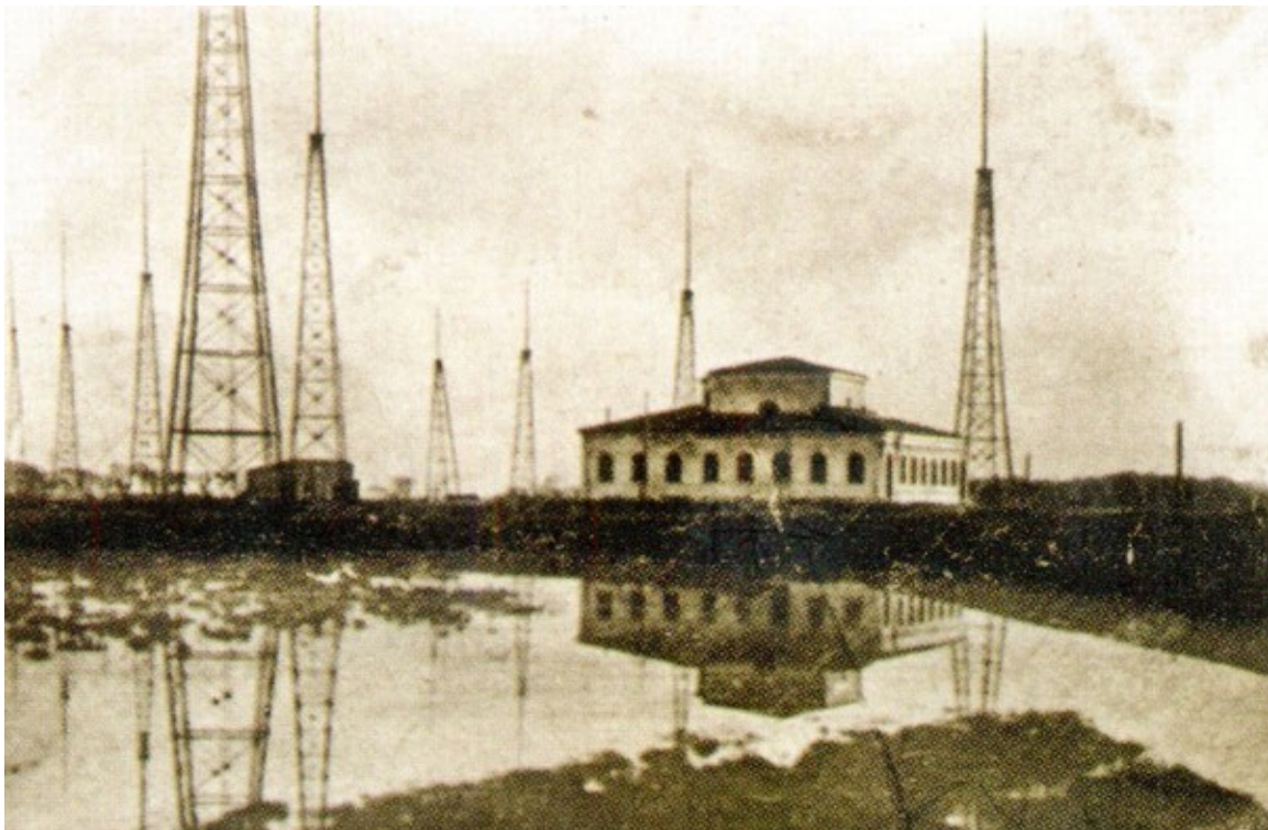
Les pylônes hauts 75 mètres
