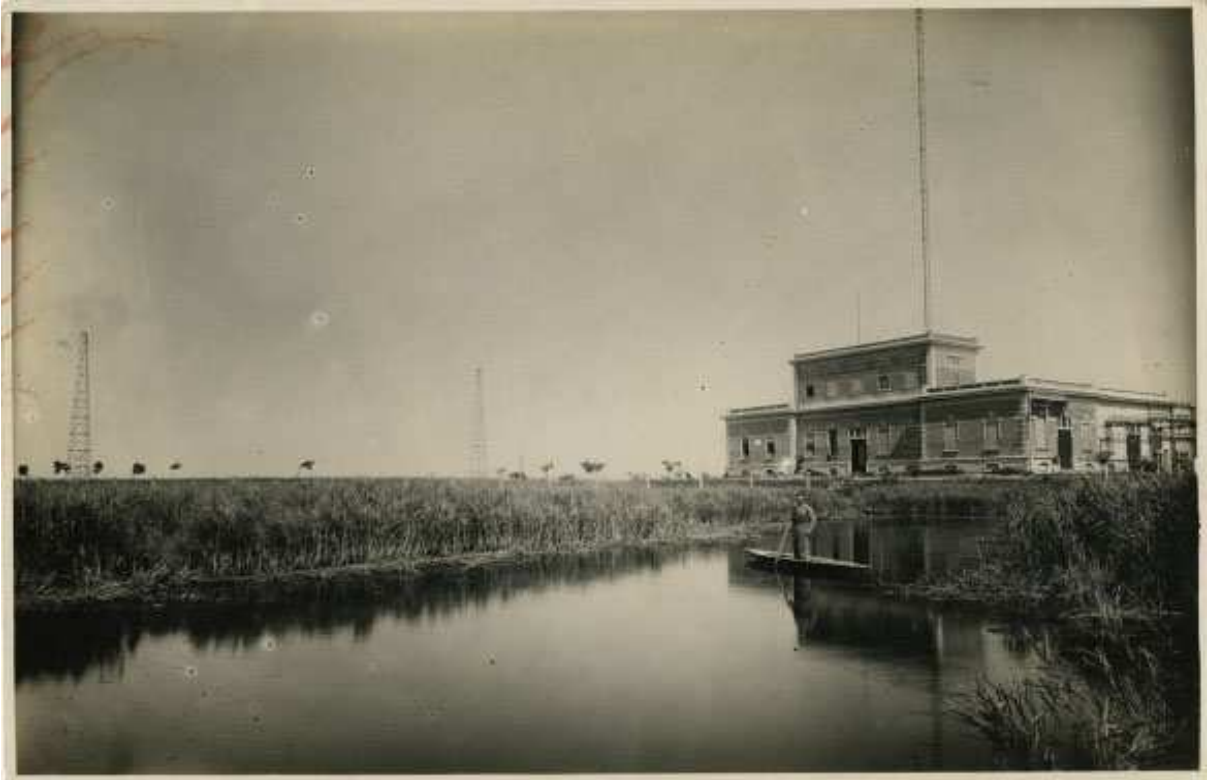
Le bâtiment de la Régie Marine construit entre 1919 et 1924 siège de la II e Station R.T.
